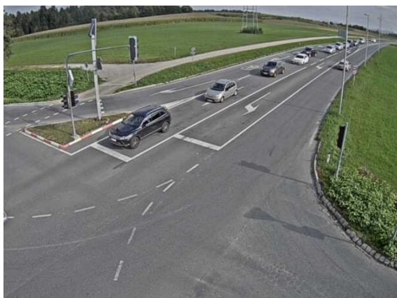
Slika 3: križišče Polica v bližini priključka Kranj-zahod
